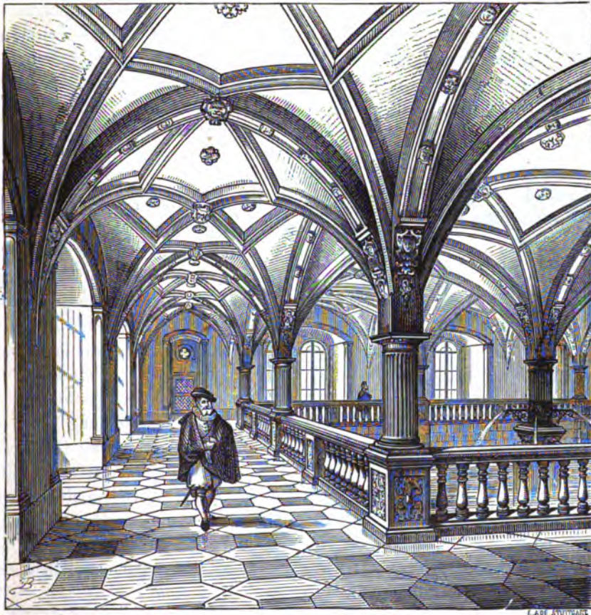
Fig. 116. Bassinhalle im ehemaligen Lufthaus zu Stuttgart.
